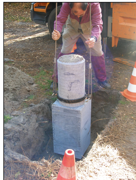
Plaatsing van nieuwe grenssteen nr 260b
